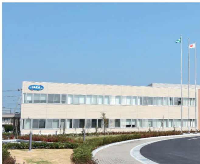
本部 総合管理棟
